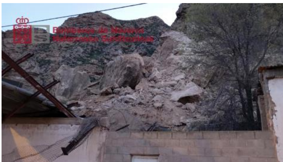
Fotos del derrumbe de una ladera en Azagra
